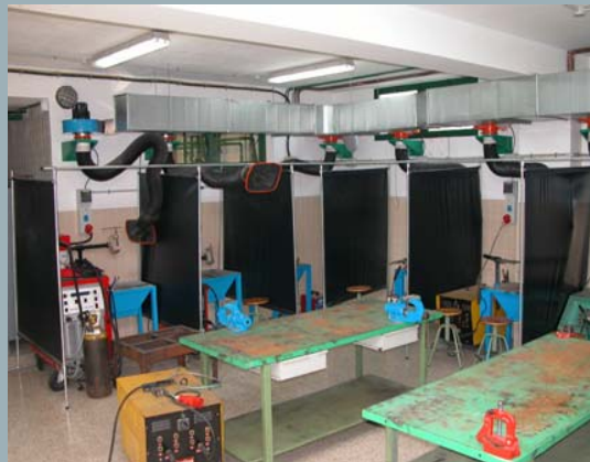
Taller de soldadura
